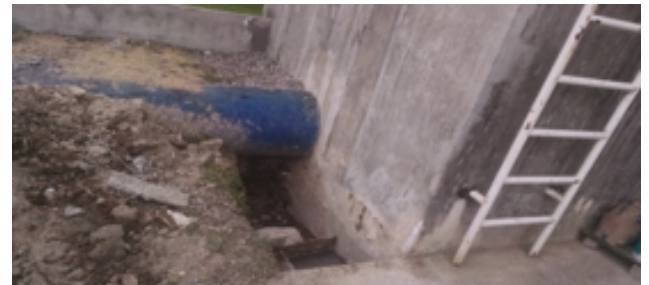
Reparación de fuga en vertedor número uno.
