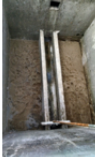
Planta de Filtros: Reparación de filtros (9 y 11).
