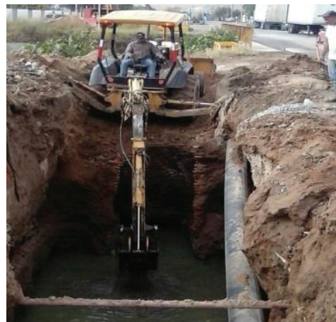
REPARACIÓN DE DRENAJES SANITARIOS
