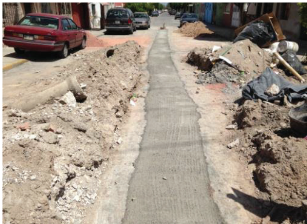
Sustitución red de drenaje sanitario de calle Laguna de Términos
