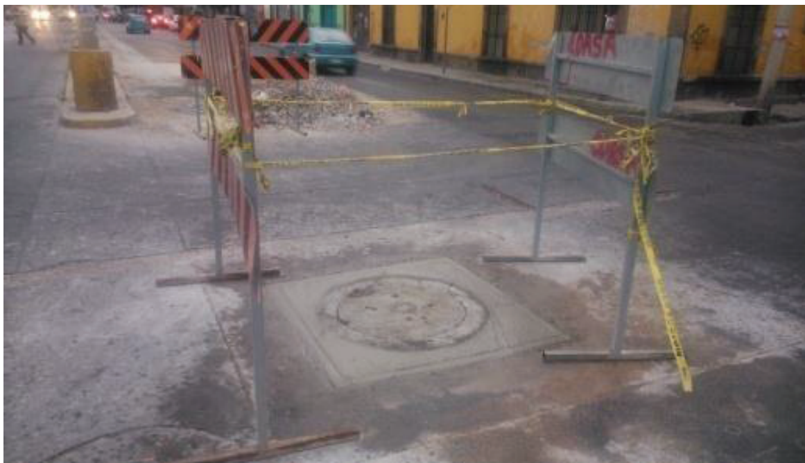
REPOSICIÓN DE BROCALES Y REJILLAS
