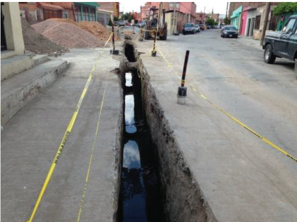
Sustitución red de drenaje sanitario de calle Simón Díaz
