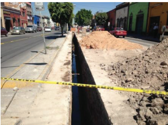
Sustitución red de drenaje sanitario de calle Simón Díaz
