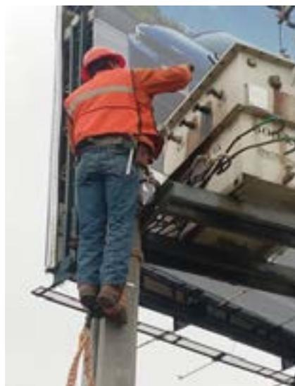
Maniobras de desinstalación de transformador para llevarlo a taller.
