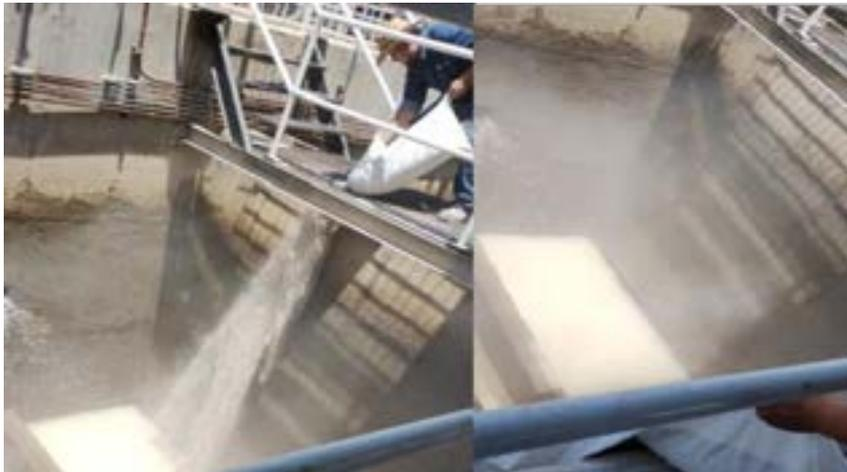
Se llevo a cabo la extracción de las lamelas alta tasa del sedimentador que corresponde al módulo 3, ya que estas presentaban un gran deterioro, provocando que las partículas comenzaran a aglomerarse en los filtros y por ende a lavar con mayor frecuencia.
