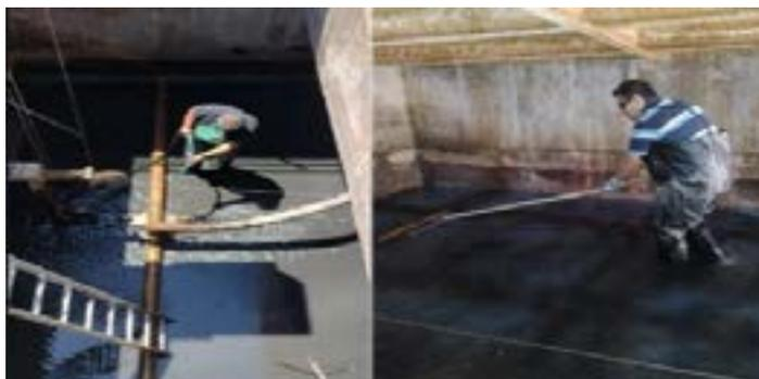
Debido a que el agua de retorno proveniente de los equipos TRALF contenía arena y otros sedimentos se llevaron a cabo la limpieza y extracción de la misma de la caja de mezcla a la entrada de los módulos en la planta, de esta manera quedó limpia y libre de sedimento.
