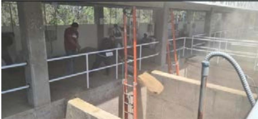
Se sustituyó el medio filtrante (arena) ya que había cumplido con su vida útil y capacidad de filtración por lo que una vez que fue extraída de los filtros para posteriormente ser rellenos con zeolita, la cual demostró una notable mejoría en el proceso, así como en la calidad del agua..
