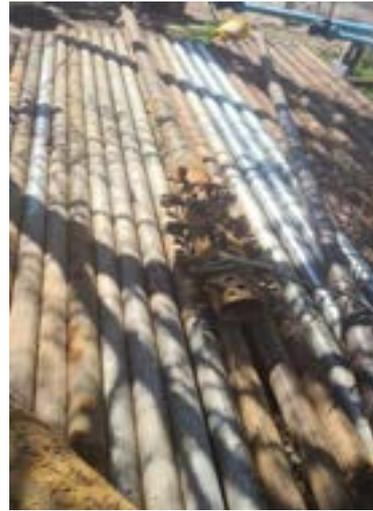
Rehabilitación realizada con maquina tipo pulseta, la cual incluye: Cepillado, pistoneo y cuchareado para limpiar todo el ademe desde el inicio hasta la profundidad final del pozo.
