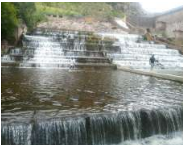
Presa San José
